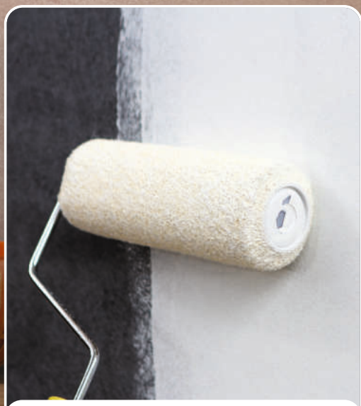
Gruntowanie Grunt Szczepny Jedna warstwa
