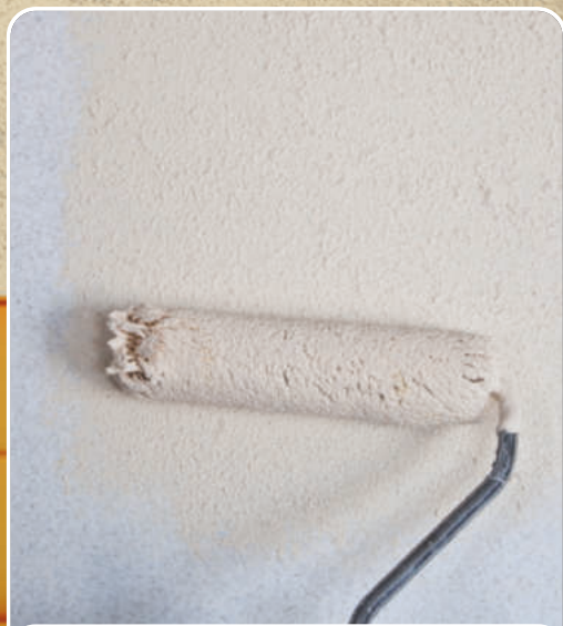
Nakładanie Baranek Dwie warstwy
